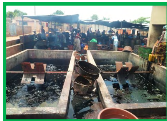
Photo 2 : Bassin de collecte du centre de teinturerie
