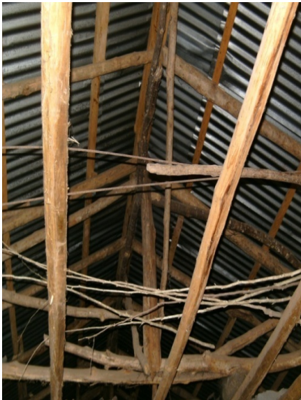
Photo 8. Une charpente avec le bois de Mansonia altissima (Photo. Isaac Vitoekpon, 2011)
